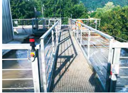
Jakość ścieków w oczyszczalni Brivio uległa poprawie.
