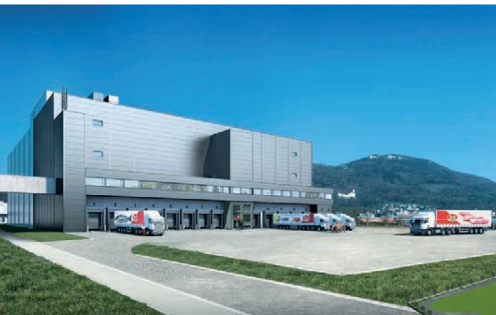
L'entrepôt frigorifique atteindra bientôt une hauteur d'environ 30 mètres.
