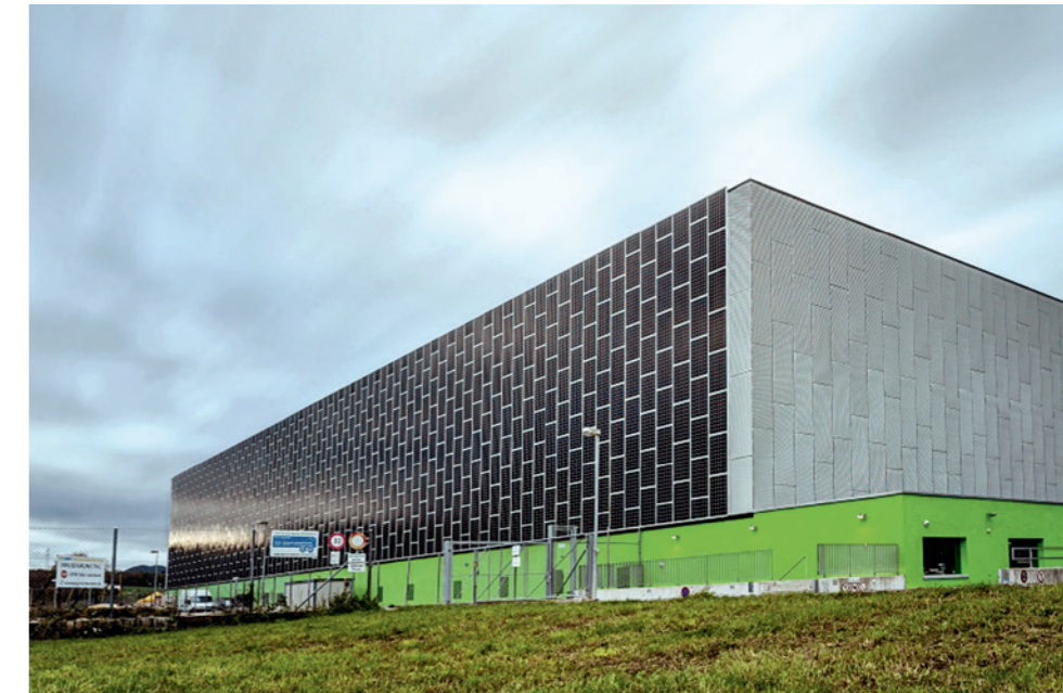
Het Green Datacenter in Lupfig
